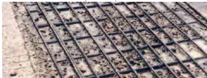
Σχήμα 3: Αποδιοργάνωση σκυροδέματος και αποκάλυψη οπλισμού με υδροκοπή (hydrodemolition)
