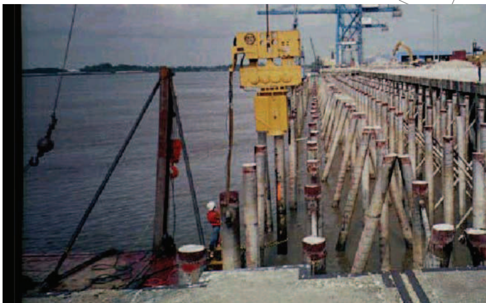
Σχήμα 1 - Εξόλκυση μεταλλικών πασσάλων λιμενικού έργου με την χρήση δονητικού πασσαλοπήκτη/ εξολκέα
