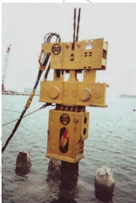
Σχήμα 2 -Εξόλκυση πασσάλων από οπλισμένο σκυρόδεμα με την χρήση δονητικού πασσαλοπήκτη/ εξολκέα
