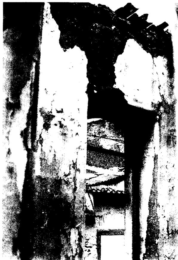
**Σχήματα 7, 8.** Πέργαμος, διώροφη λαϊκή κατοικία, ενίσχυση των τοίχων του ορόφου από ξύλινους σκελετούς. Αριστερά, η βάση του σκελετού και, δεξιά, η κορυφή του. Η ομοιότητα με το δομικό σύστημα της Ερεσού είναι παραπάνω από εμφανής (βλ. Σχήμα 4).
