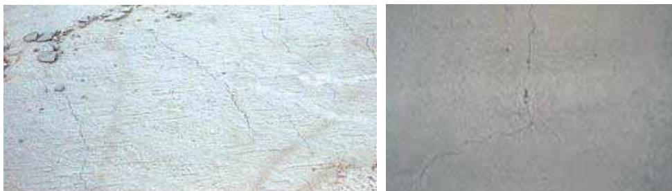
Σχήμα 1 - Ρηγμάτωση σκυροδέματος σε πλαστική κατάσταση
