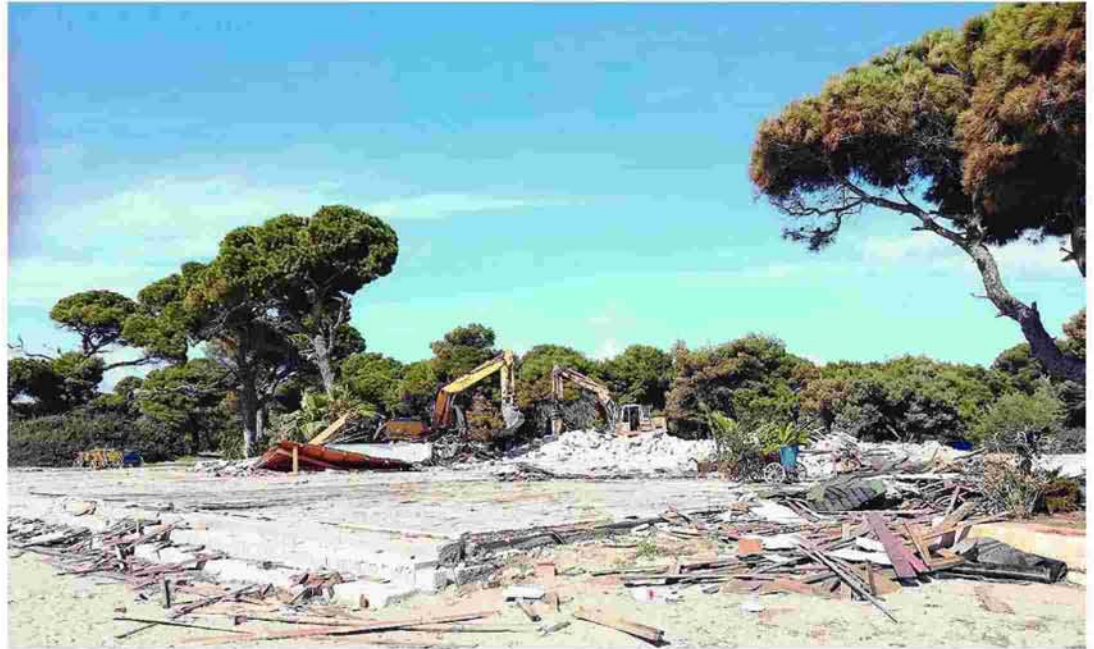
Από κατεδάφιση στον Σχινιά. Εικόνα σπάνια στις περισσότερες περιοχές, καθώς κατεδαφίσεις δεν γίνονται, συχνά μόνο με το πρόσχημα έλλειψης πόρων και προσωπικού.
