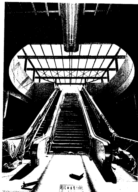
Οι εργασίες της επέκτασης Αγ. Δημήτριος - Ελληνικό του μετρό «τρέχουν» με γοργούς ρυθμούς παρ' όσα περιλαμβάνουν σύνθετες και πολύπλοκες κατασκευαστικές εργασίες.
