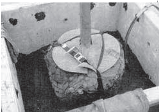
Εικόνα 1 - Υπόγεια στήριξη δένδρου με χρήση γεωυφάσματος
