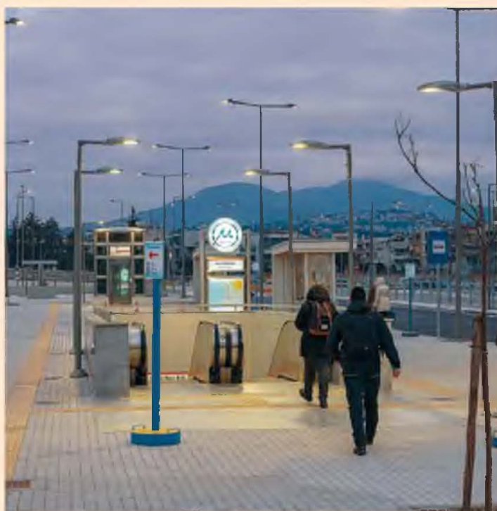
Αυτή την περίοδο έχουν ξεκινήσει οι πρώτες δοκιμές μετά την ενεργοποίηση της ηλεκτροδότησης της γραμμής.
