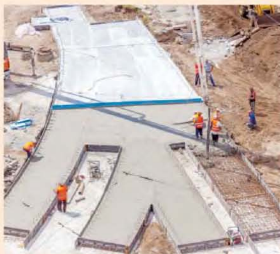
Τα τέσσερα οδικά έργα αφορούν την αποκατάσταση ζημιών από τις θεομηνίες «Daniel» και «Elias» σε Θεσσαλία και Εύβοια.
