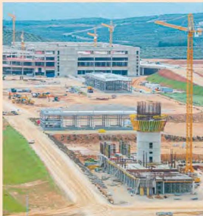
Προς ολοκλήρωση οδεύουν σταδιακά οι βαριές κατασκευαστικές εργασίες για το νέο διεθνές αεροδρόμιο στο Καστέλλι, το οποίο θα εκτείνεται σε συνολική έκταση 6.030 στρεμμάτων.
