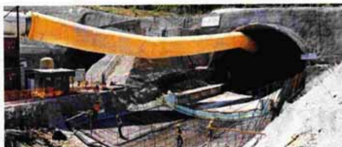
Εναν χρόνο μετά την επανεκκίνηση των εργασιών, επαναλαμβάνεται το σκηνικό του 2010. Μεγάλοι οδοικοί άξονες που κατασκευάζονται με τη μέθοδο της σύμβασης παραχώρησης οδηγούνται εκ νέου σε αναστολή
