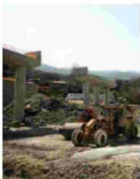
Για μεθόδευση καταστροφής του κατασκευαστικού κλάδου κάνει λόγο σε ανακοίνωσή του ο Σύνδεσμος Τεχνικών Εταιρειών.
